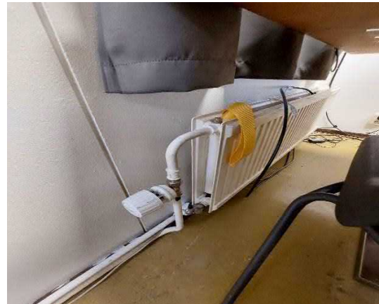
Uusittu patteriventtiili ja termostaatti.
