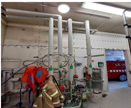
Nykyinen kaukolämpökeskus ulkoisesti siistissä kunnossa, ympärillä runsaasti sinne kuuluma-tonta tavaraa.
