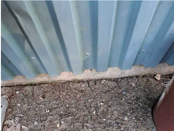
Profiilipelti laskeutuu sokkelirakenteiden päälle
