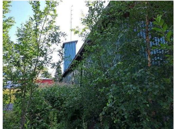
Rakennuksen takana runsaasti kasvillisuutta
