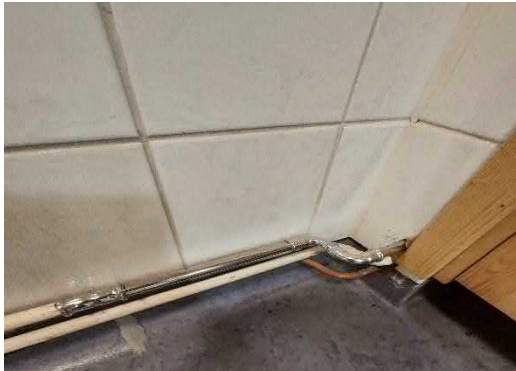
Kylpyhuonetiloissa korjattuja putkiosuuksia.
