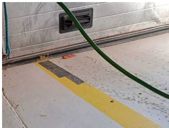
Pinnoitevaurioita uusituslaattarakenteissa
