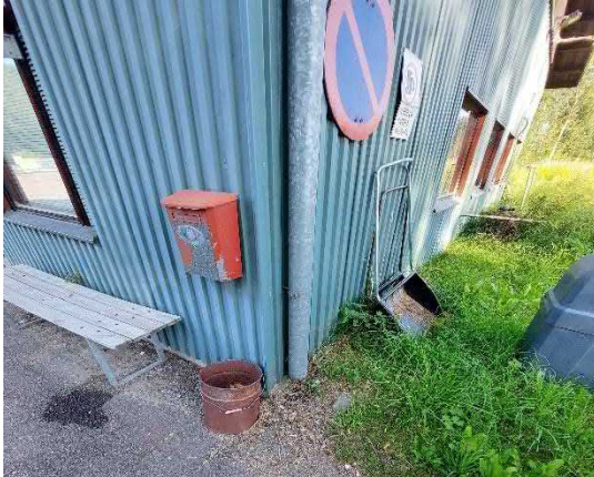
Kattosadevedet lasketaan rännisyöksyjä pitkin sokkelin viereen.
