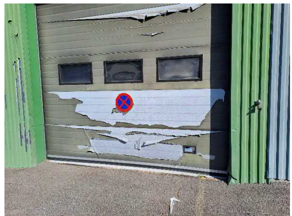
Traktoritallin nosto-ovesta irtoaa pinnoite
